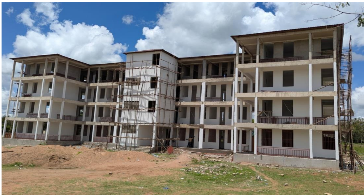
Mwonekano wa ujenzi wa hosteli za wanafunzi unaoendelea katika Chuo cha Maendeleo ya Michezo Malya. Hosteli hiyo itakuwa na jumla ya sakafu nne (4) itakapokamilika na itakuwa na uwezo wa kuchukua wanachuo 192.
